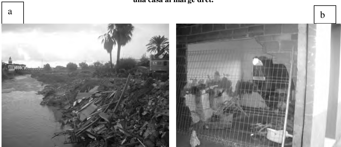
Fig. 10. Casa del Verger derrocada pel riu al marge dret; b) forat obert per l'aigua en travessar una casa al marge dret.
