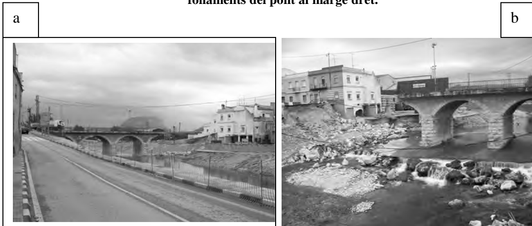
Figura 8a. Erosió al pont de Beniarbeig, vist des d’amunt. Les fletxes indiquen la trajectòria de les línies de màxima velocitat a un meandre i les zones erosionades a la marge dreta del riu; b) Vista des d’avall. Es pot observar la ubicació de les cases damunt del point bar i la sapa dels fonaments del pont al marge dret.
